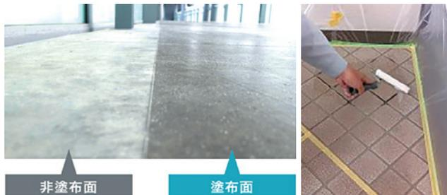
▲床の柄を損なわない透明な滑り止め塗装材「クリアグリップ」と塗装工事の様子
