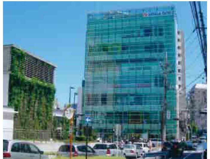
浦和駅東口駅前「スミダビル」
